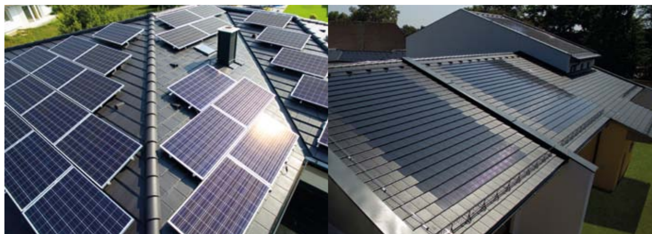
Klaičen solarni sistem s velikimi paneli.
