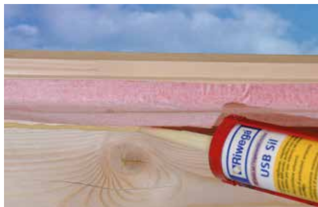
Lepljenje notranjega traku FDB INT AC na les.
