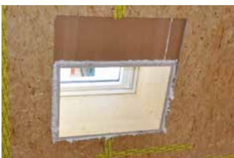
Tesnjenje špranj okrog obsega strešnega okna
