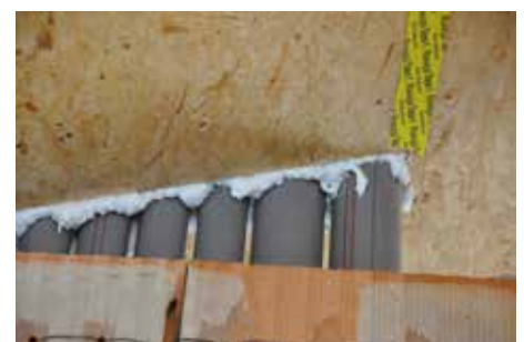
Zapolnitev razpok, lukenj ali stikov med gradbenimi elementi
