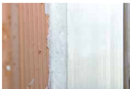
Zapolnitev praznine med slepim podbojem in zidom
