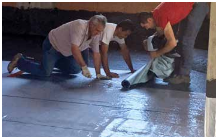
Polaganje zapore za radon USB Coll Radon BIT
