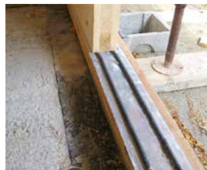
Tesnenje podpore lesene stene.
