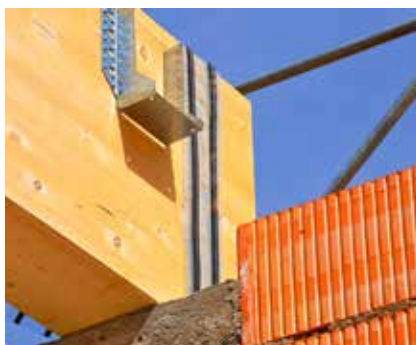
Tesnenje trama na zidu.
