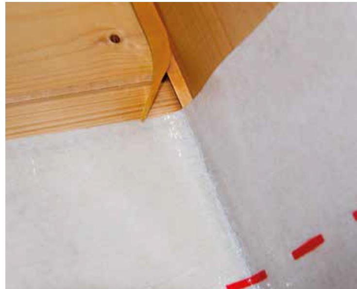
Za zagotavljanje pritrditve na strukturo brez preluknjanja parne ovire in za totalno hermetičnost sistema se lahko uporabi trak USB Tape 2 AC BOLD (Art. 02040210). Akrilno lepljivo maso ojačamo z mrežico iz poliestra, ki močno lepi, je viskoelastična in širša ter namensko izdelana za lepljenje in tesnjenje parnih ovir in zapor na kateremkoli tipu gradbene podlage (les, zidovi, ometi, cement, kovina itd.).
